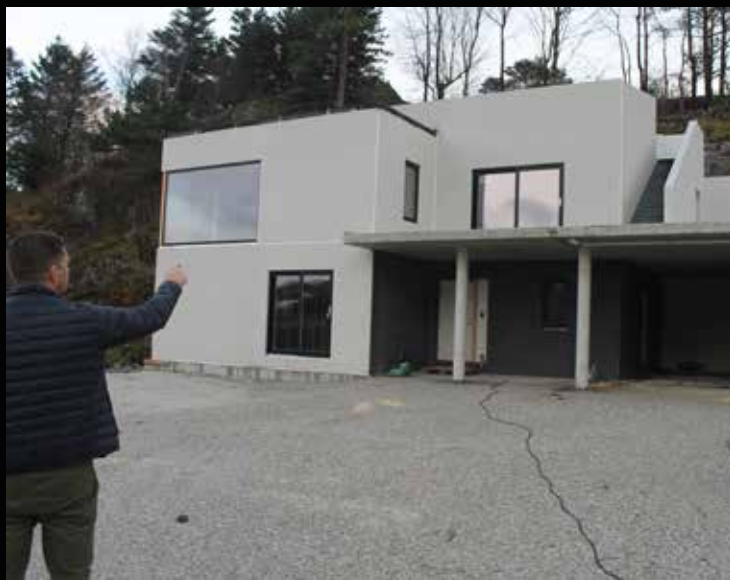
Denne boligen i Hamraneveien på Eigerøy er på vei til å bli ferdig. Hele boligen er bestående av betong. Egersund Betongteknikk sammen med sine samarbeidspartnere behjelpelige med å levere nøkkelferdige boliger til sine kunder.
